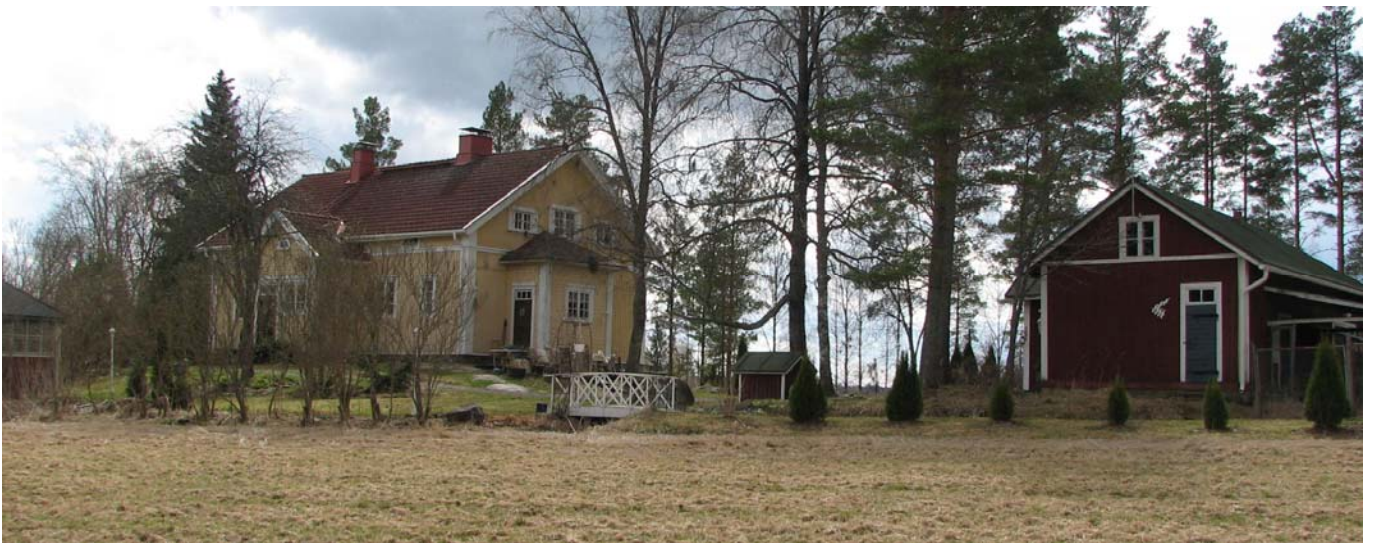
Kuva: rakennukset pohjoispuolen pellolta kuvattuna
