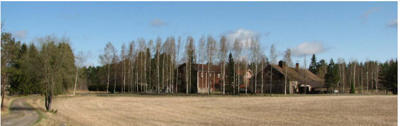
Pietilän laajasta rakennuskokonaisuudesta talli ja navetta muodostavat merkittävän osan Pohjantien raitinäkymää. Asuinrakennus jää rakennusten taakse. Kuva on otettu rantaan menevän tien varrelta, ns. tuulimyllyladon kulmalta.
