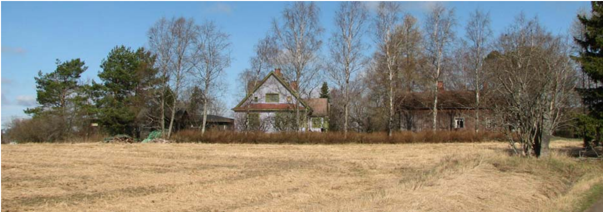
Vesan rakennuksia kaakosta kuvattuna keväällä 2009. Kuvassa näkyvät asuinrakennus ja pakari
