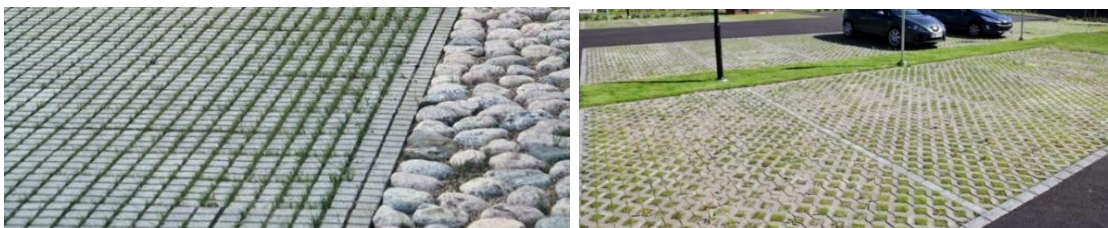
Parkkiruudut erotettu muista liikenneväylistä luonnonkiviraidalla ja nurmikivilaataalla. (kuva: Benders Oy ja Rudus Oy)
