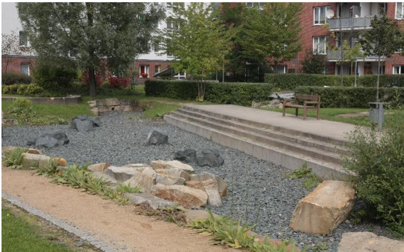
Kuva 11. Sateiden välillä tyhjentyvä viivytysallas kerrostalopihalla.
